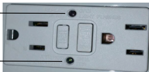
Figura 3. Leuchten an der NEMA 5-15-Steckdose
